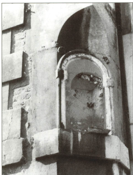
Détail de la façade de l'Hospice Saint-Gilles. "Niché en plein cintre en boudin sur imposte saillante avec écoinçons de rosettes".
